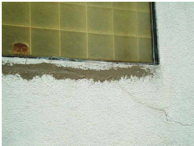
Transformatoren-Station Eglispor vorher
