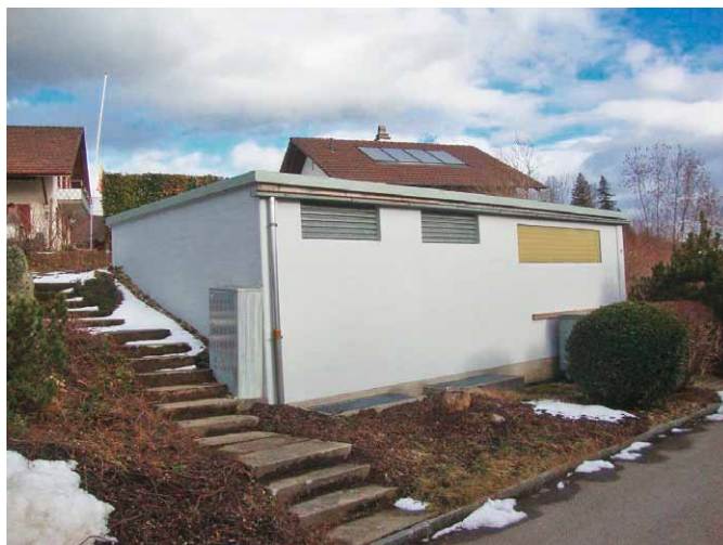
Transformatoren-Station Eglispor nachher
